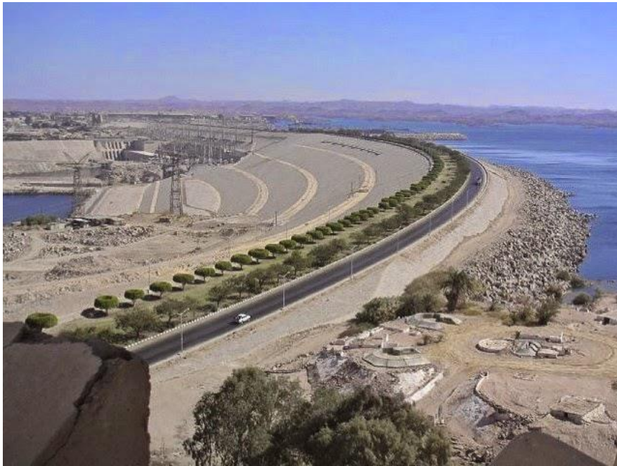
Φράγμα του Ασουάν-Νείλος
