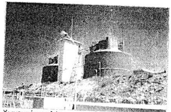
Χωνευτήρες ιλύος για τη παραγωγή βιοαερίου στις εγκαταστάσεις της ΔΕΥΑΧ στο Κουμπελή
