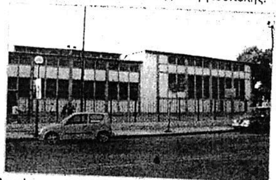
Άποψη του κτηρίου στη Λίμνη του Δήμου Χανίων όπου παλαιότερα λειτουργούσε θερμοηλεκτρικός σταθμός και σήμερα στεγάζεται το Αθλητικό Κέντρο Χανίων
