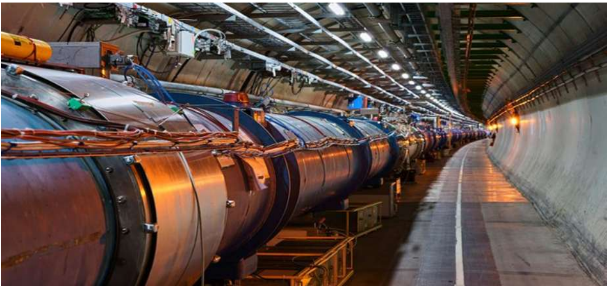
Ο τεράστιος κυκλικός Αδρονικός επιταχυντής LHC, με μήκος 27 χιλιομέτρων, αποτελείται από χιλιάδες χιλιόμετρα καλωδιώσεων, ηλεκτρομαγνήτες και ερευνητικές συσκευές με δεκάδες δισεκατομμύρια τρανζίστορ.
